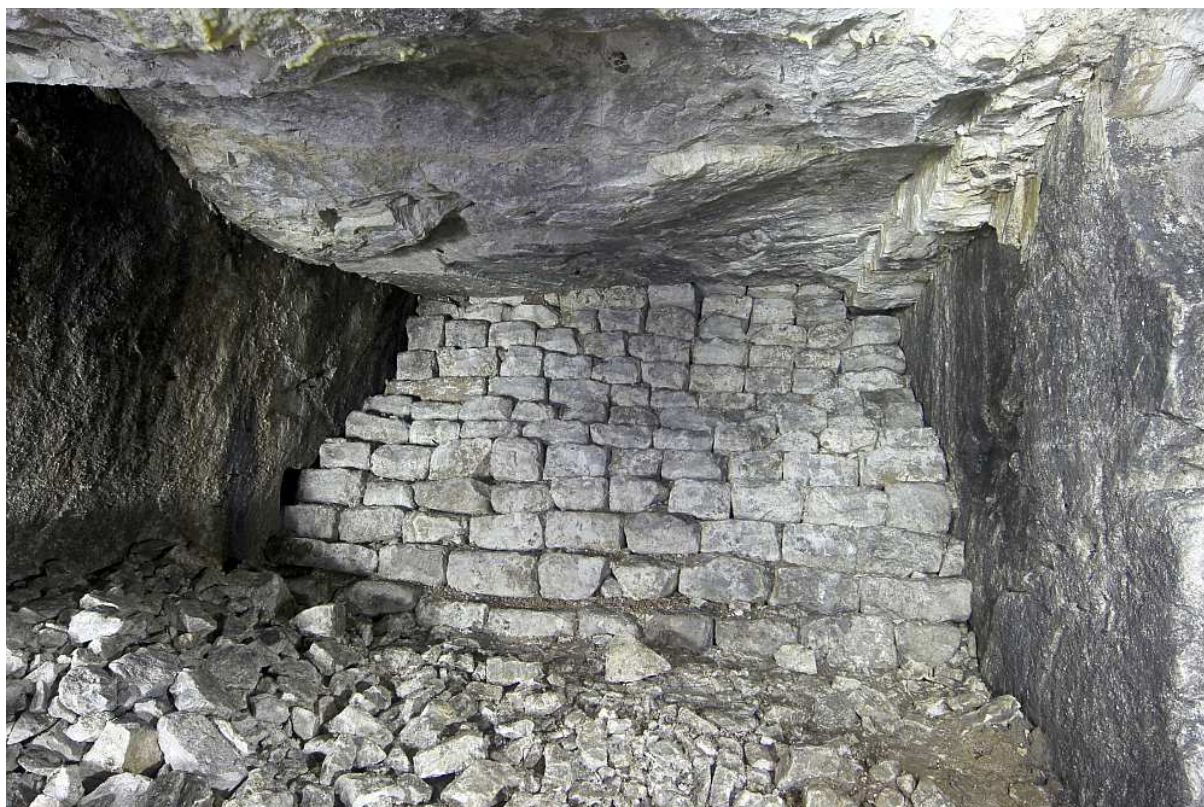
Le mur du trésor des Barbeuses
